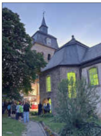
die Ev. Kirche Krumpa verfügt über Glasfaser
