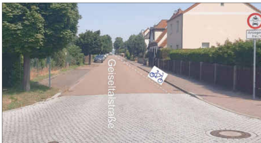
Bild 2: Radstreifen Geisetalstraße innerorts - Bereich zwischen Kreuzung Schiefweg und Lindenstraße Breit: 1,25 m
