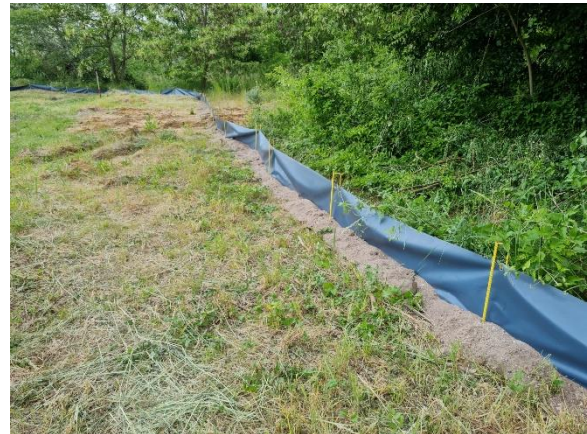
Abb. 2: siehe Abb.1 Detail überdeckte Umschlagseite, fachgerechter Aufbau
