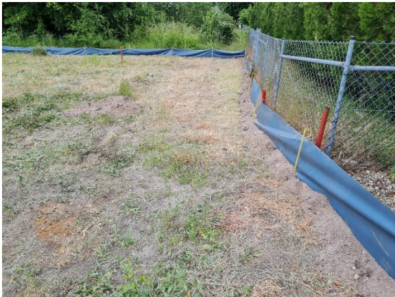
Abb. 1: Aufgebauter Reptilienschutzzaun im Juni 2023 Bereich Einbeziehungssatzung
